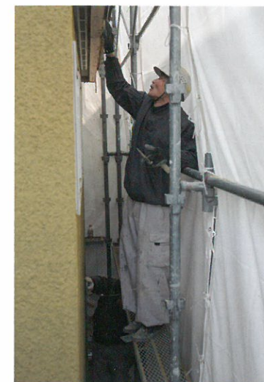
▲足場の上での作業に精が出る
