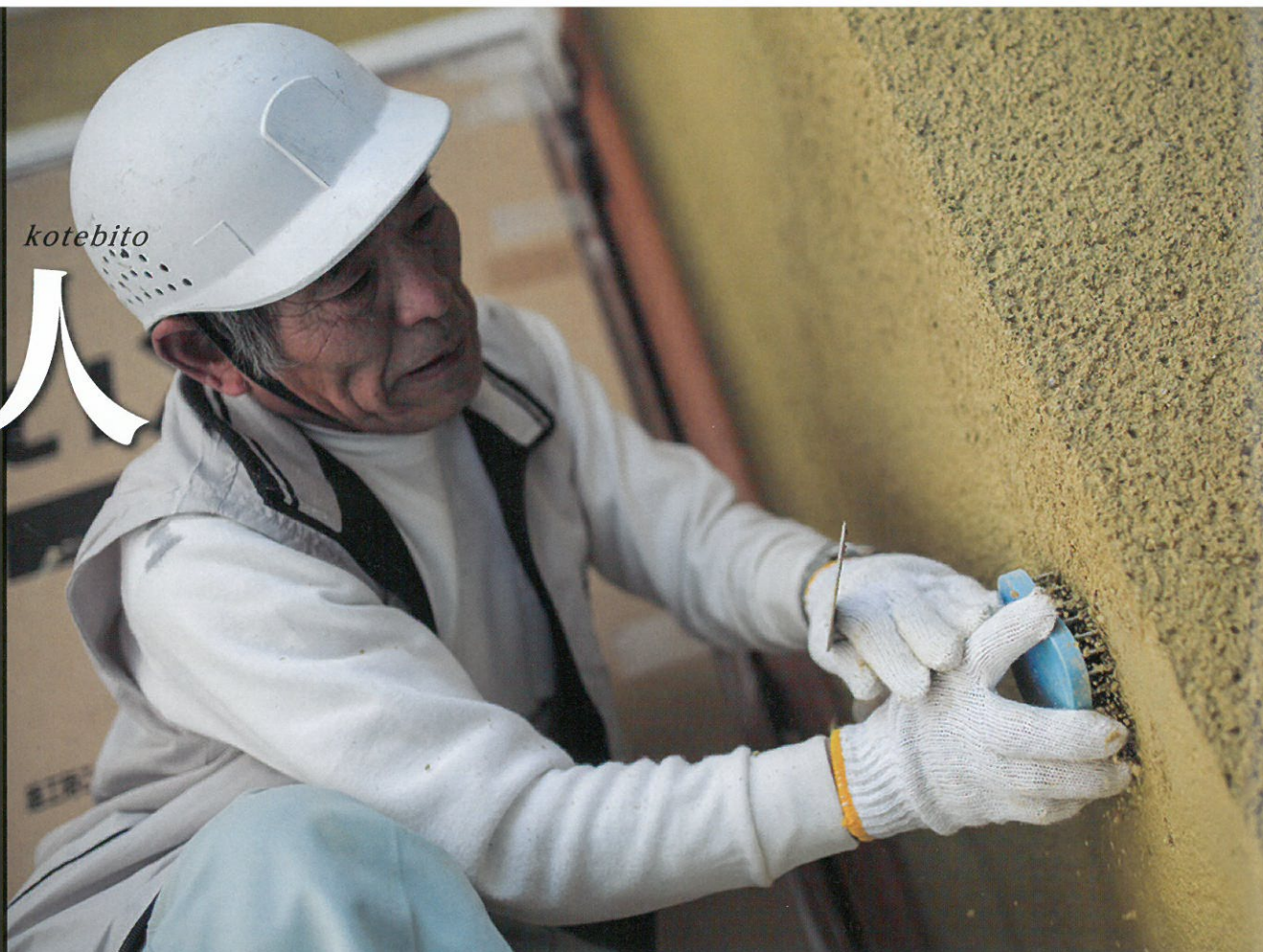
▲職人歴50余年の中川さんは、無駄のない動きでシラス壁を仕上げにいった外装材：スーパー白洲そとん壁W かき落とし仕上げ
